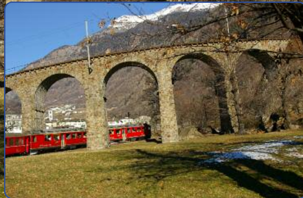
Il Viadotto elicoidale di Brusio
