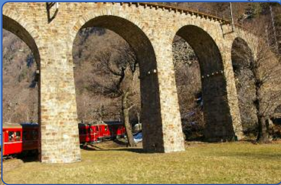
Il Viadotto di Brusio
