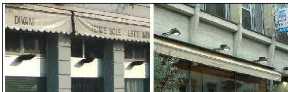
*Fig.21 – Nella foto di sinistra una vetrina illuminata erroneamente dal basso verso l'alto. In quella di destra invece l'illuminazione è conforme alla LR17/00. Se la vetrina di destra fosse conforme non necessiterebbe ne di progetto ne di autorizzazione dell'autorità competente ai fini della conformita' alla LR17/00.*
