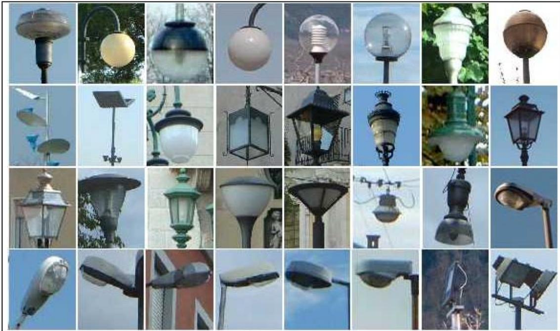
Fig.5 - Apparecchi d'illuminazione che è possibile trovare nelle nostre città NON conformi alla L.R. 17/00.
