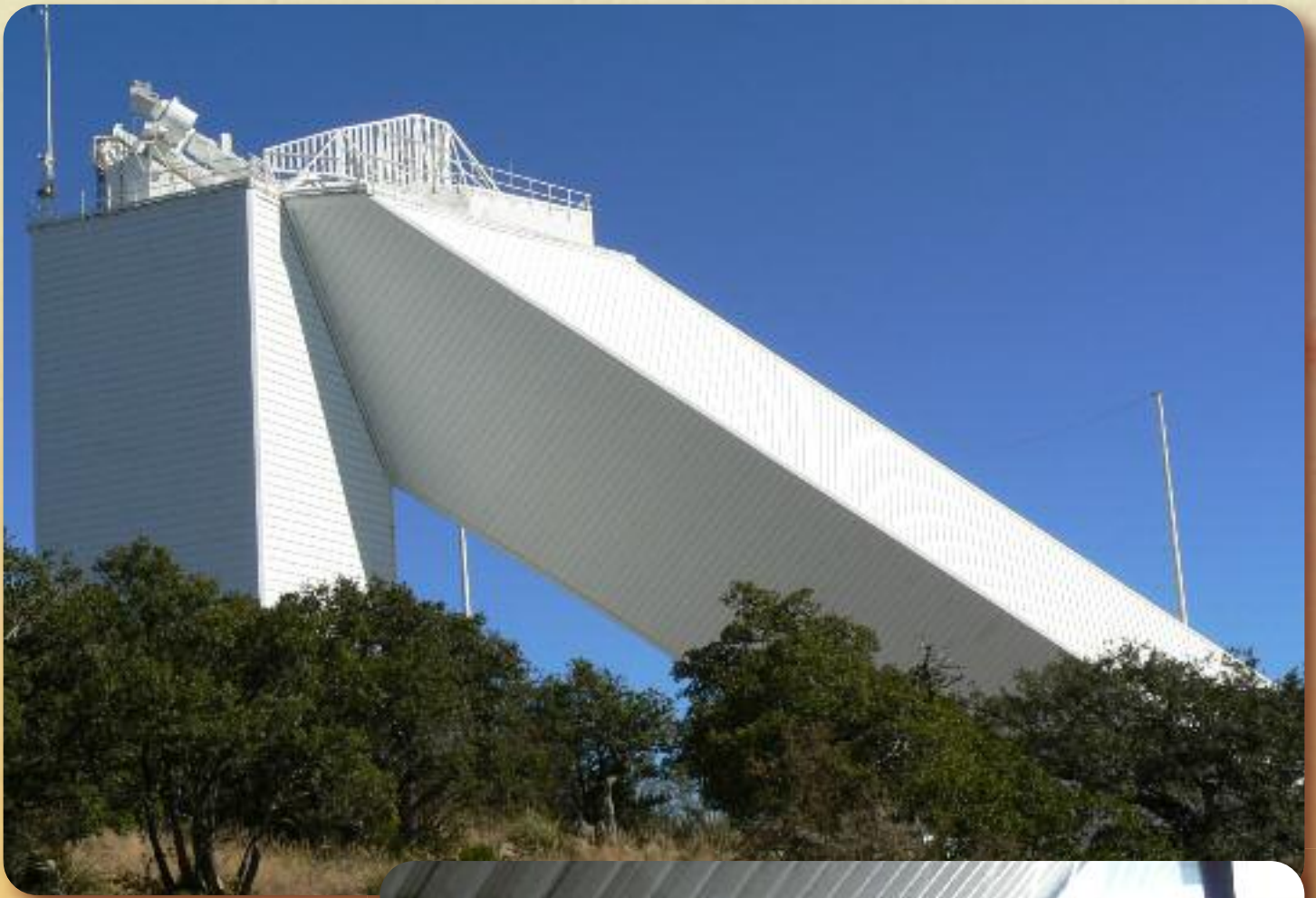
La torre solare
