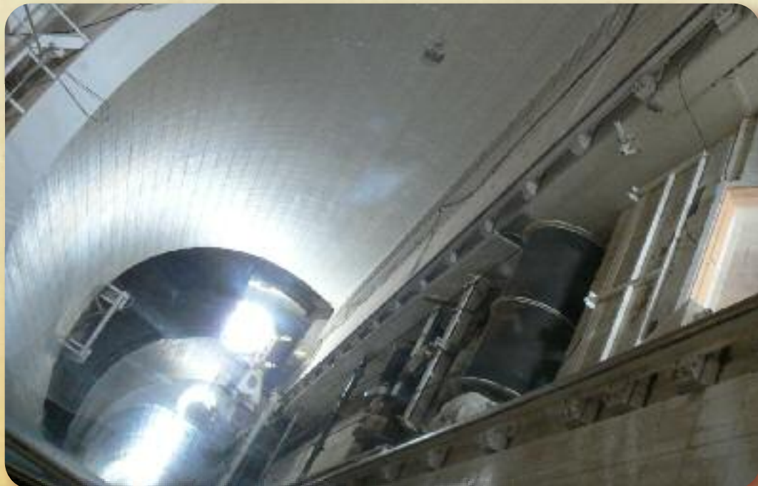
Interno della torre solare
